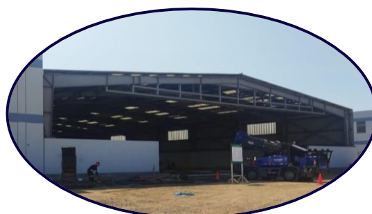
CONSTRUCCIÓN E IMPLEMENTACIÓN NUEVA BASE AERONAVAL
